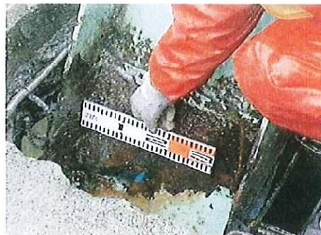
写真2 トラス橋斜材のコンクリート床版貫通部の腐食
