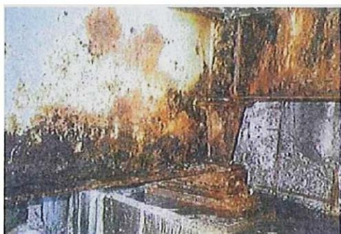
写真1 支点部周辺の腐食
