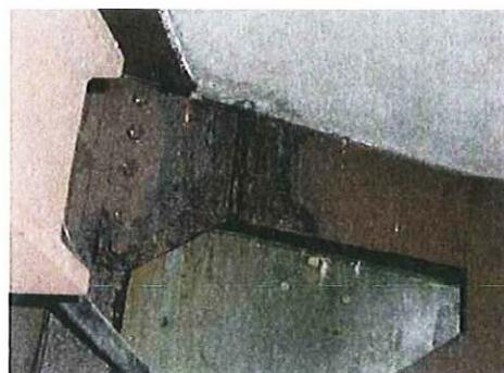
写真4 耐候性鋼橋梁端横桁の層状はく離さび
