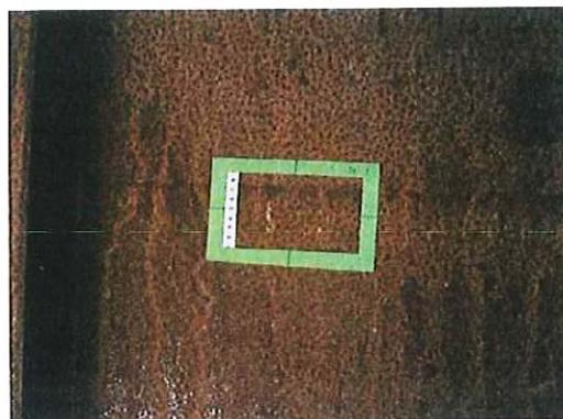
写真4 経過15年 さびの大きさが最大2mm
