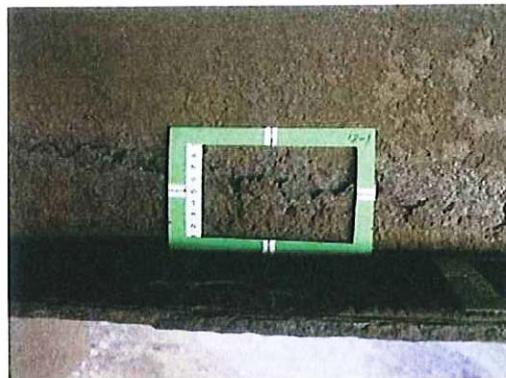
写真2 経過37年 さびの大きさが最大5mm
