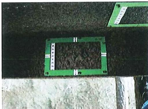
写真3 経過17年 さびの大きさが最大5mm
