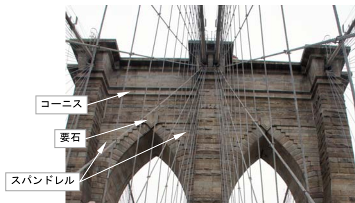
図-16.2 主塔アーチ部石積構造
