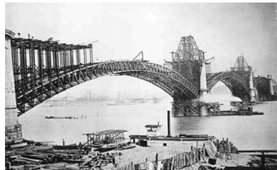
図-16.3 架設中のイーザ橋 (セントルイス橋とも呼ばれる)
