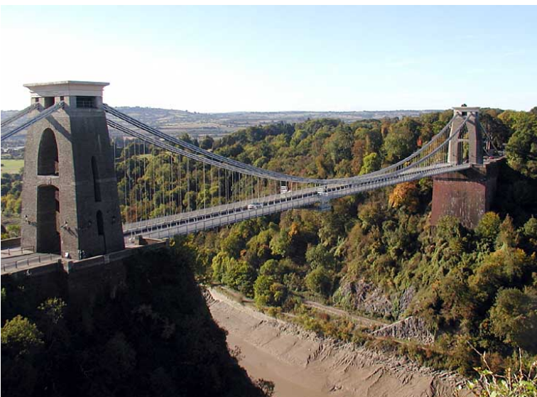
図-7.9 クリフトン吊橋(1864年開通) 最大径間長214m, 幅員9.4m, 桁下空間75m
