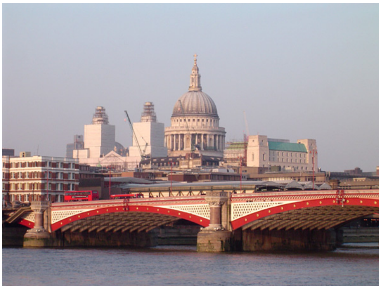
図-7.8 ブラックフライアーズ橋(1869年開通) 橋長281m, 5径間, 幅員21m(当初)
